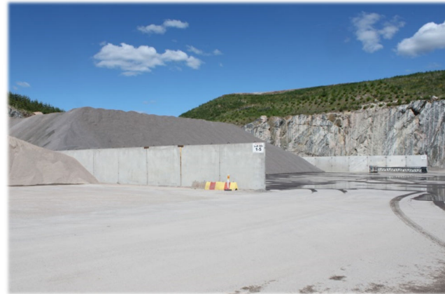
Kuvat 10 ja 11. Kasteltu kiviauton kuljetusreitti. Alueen kiviainestuevarastot on merkitty selkeästi.
