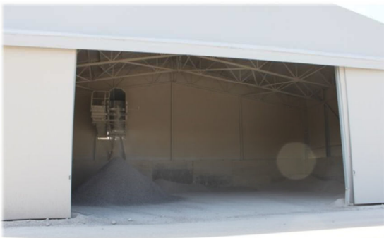
Kuva 20 ja 21. Hiekoitusshiekan kuljettimen pää hallissa. Kuljetinten päissä oleva kastelu estää tehokkaasti kiviainekasojen pölyämisen.
