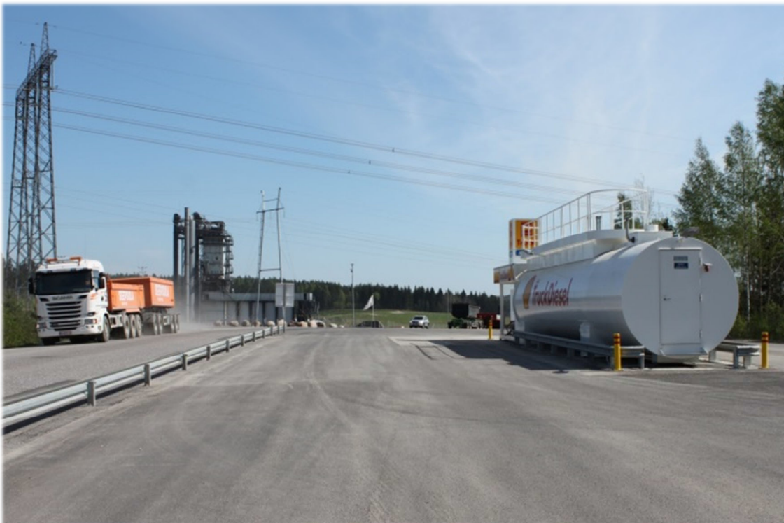
Kuva 4. Dieselpiste ja taustalla asfalttitehdas
